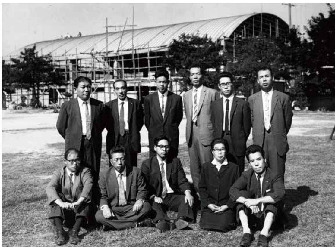
体育館（建設中）
